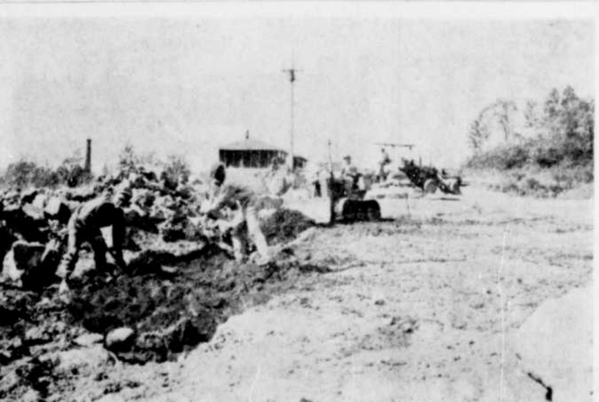
RUE ST-JEAN. — En-dehors du pavage prévu dans l'ordre de la maintenance, la municipalité de Windsor s'apprête à prolonger de quelque 350 pieds le pavage de la rue St-Jean en vertu du règlement 296. Avant le pavage, les employés municipaux s'efforcent à compléter une ligne d'égouts de surface. Dans cette partie de la St-Jean, on n'aura pas à briser l'asphalte plus tard pour installer des entrées d'eau pour les propriétaires riverains. Elles auront été faites au préalable.
