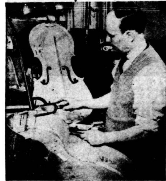
M. Forget est ici en train de réparer le premier violoncelle fabriqué par son ancien maître, M. T.-O. Dionne, en 1904. Il est la propriété de M. Melançon, de Drummondville. Le luthier tient un compas spécial pour mesurer l'épaisseur des parois des instruments à cordes. (Photo du "Petit Journal").
