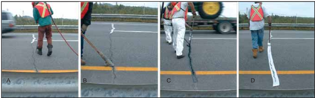
Les étapes de mise en œuvre : (a) nettoyage au jet d'air, (b) séchage à la lance thermopneumatique, (c) buse d'injection et racloir, (d) papier anti-adhérent.
