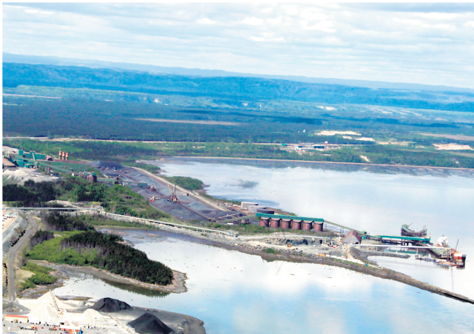
Québec cherche à acquérir les installations mises en vente par Cliffs Natural Resources dans le secteur de Pointe-Noire à Sept-Îles.
