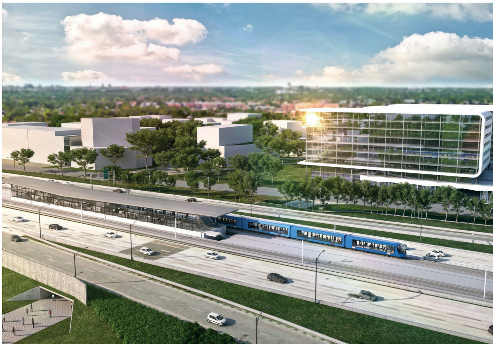
La construction du Réseau express métropolitain a débuté en avril et la Caisse prévoit que les premières rames seront mises en service à l'été 2021. CAISSE DE DÉPÔT ET PLACEMENT DU QUÉBEC
