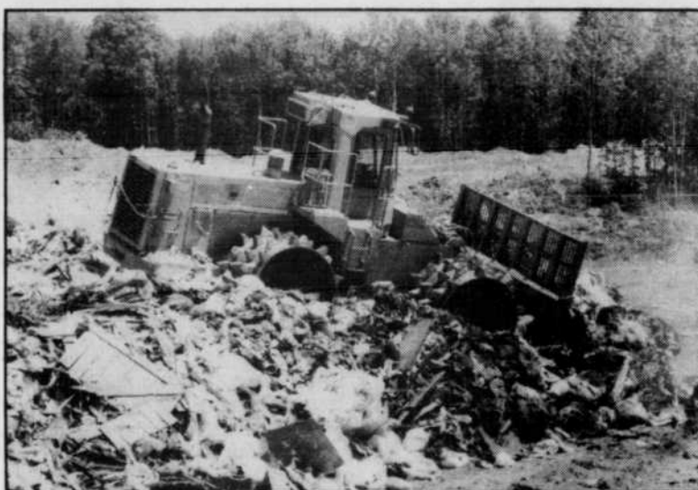
Un gros tracteur compacte les déchets d'un nouvel arrivage en provenance de Boisbriand en une couche de deux mètres d'épaisseur, qui est ensuite recouverte de trois centimètres de sable.
