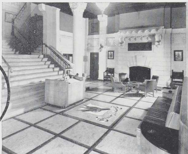
A droite: vue de l'entrée centrale de la Montreal Amateur Athletic Association—plancher recouvert de marboléum.
