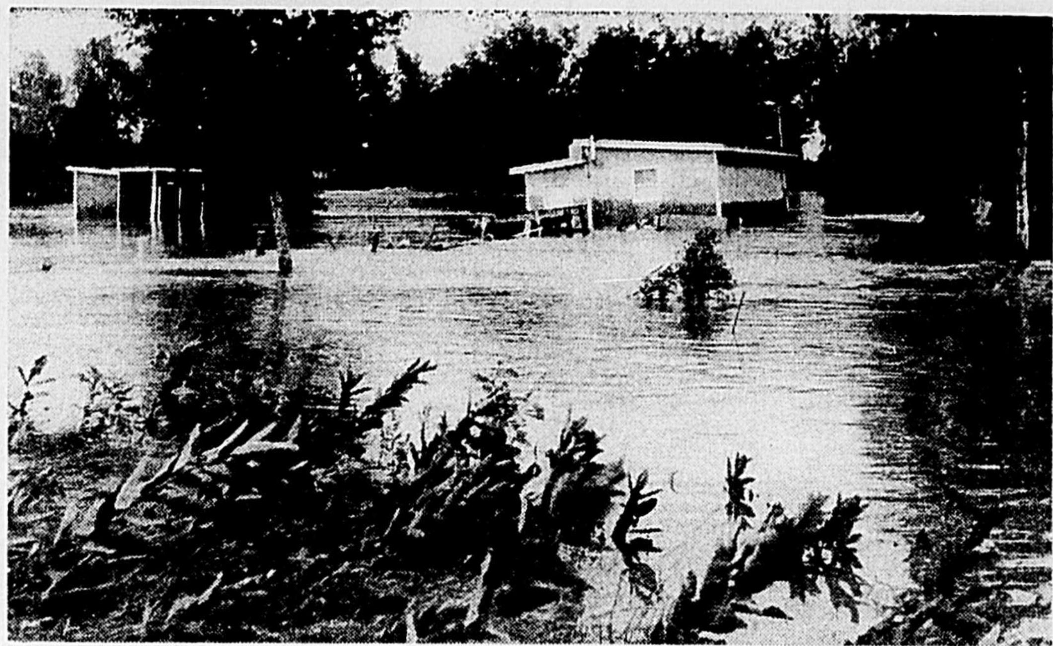
Des dégâts considérables — Des centaines de chalets bâtis sur les rives de la rivière Blanche ont subi le sort de ceux que nous voyons sur cette photo. Tout
