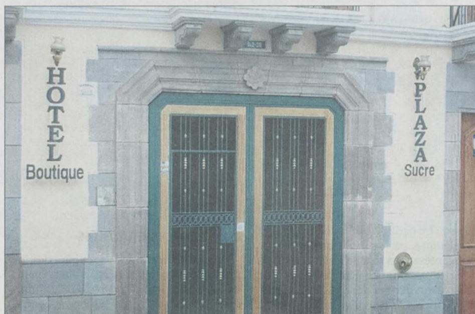
La porte d'entrée de l'hôtel Boutique Plaza Sucre, à Quito.
