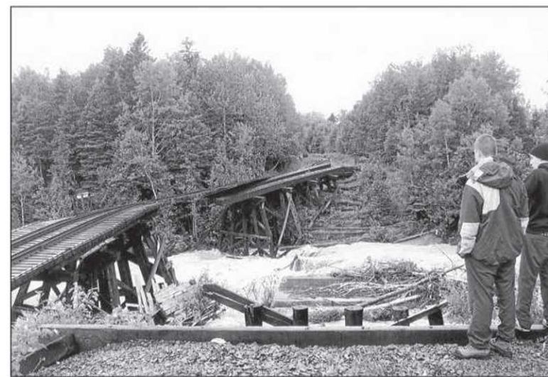
Le niveau de la rivière Stewart de Saint-Omer a augmenté de 15 pieds dans la nuit de dimanche à lundi, déplaçant ce pont ferroviaire vers l'aval. — PHOTO COLLABORATION SPÉCIALE GILLES GAGNÉ
