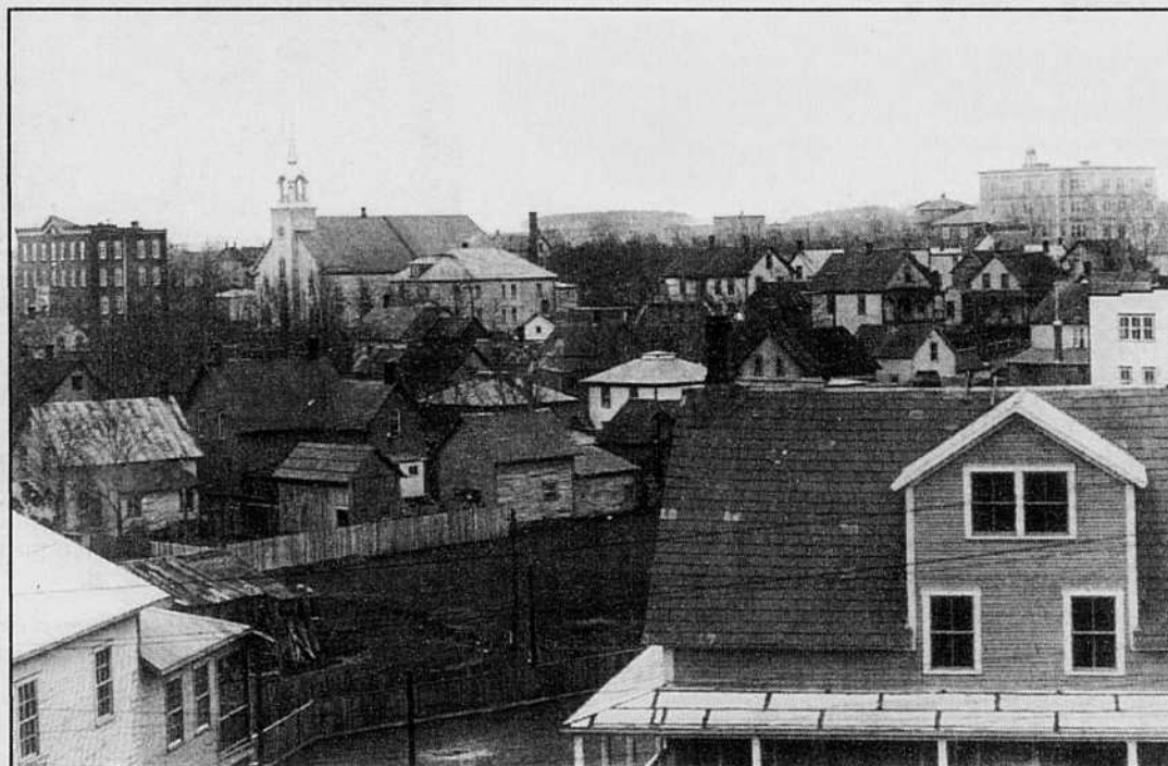
Photo: Société d'histoire d'Asbestos, Fonds G. Dubois
