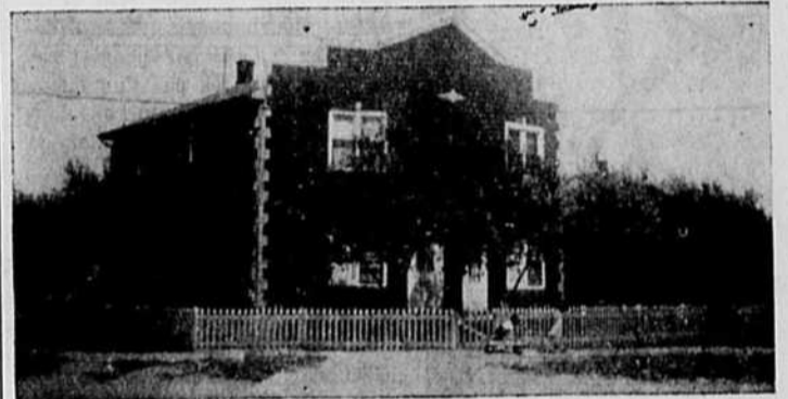
Maison de 4 logements. Plancher bois franc. Solage en ciment. Libre à l'acheteur. $4,000. comptant et balance payable par versements.
