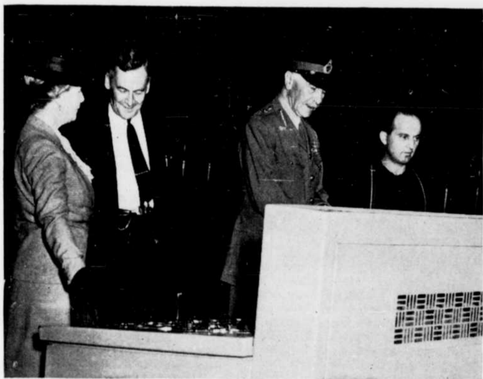
M. Jules Brassard, préposé aux panneaux de contrôle des redresseurs, domicilié au numéro 862 rue Moissan à Arvida, explique au gouverneur-général le fonctionnement de cet appareil. A gauche la princesse Alice et M. P.-H. Skelton, gérant des usines d'Arvida.
