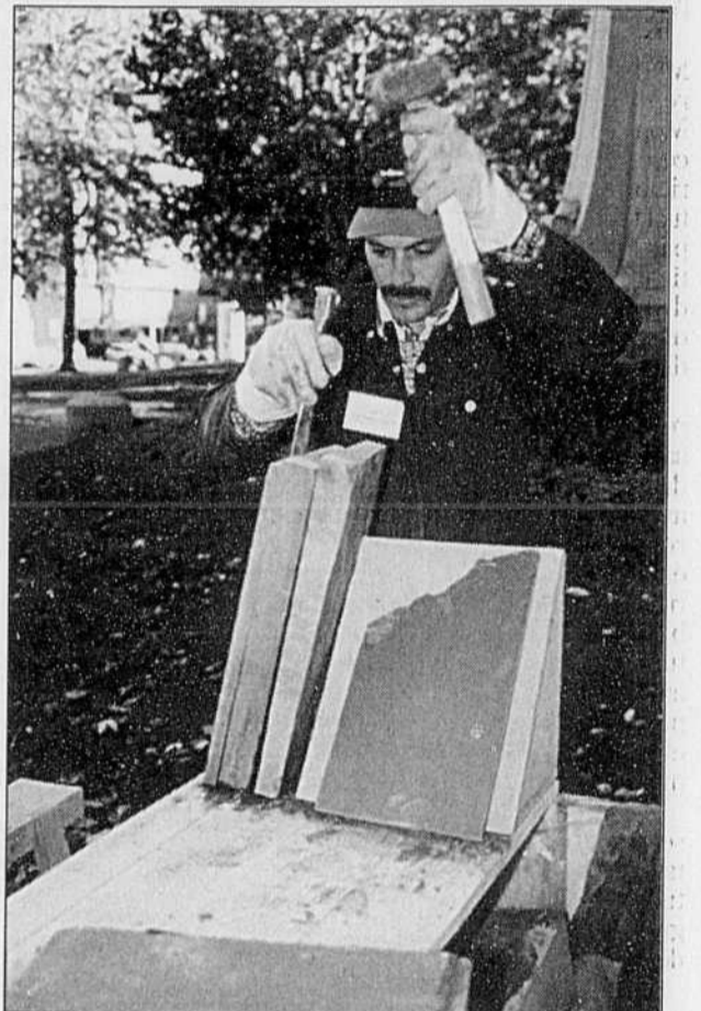
Parmi les chantiers d'envergure on trouve l'église anglicane St-George, située en face de l'hôtel Windsor. Ici, un ouvrier sépare des pièces d'ardoise.
