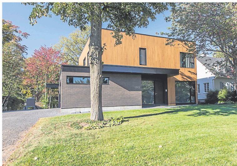
La maison située au 1295, avenue Oak, a été récompensée dans la catégorie Construction neuve (basse densité). — PHOTO FOURNIE PAR LA VILLE DE QUÉBEC
