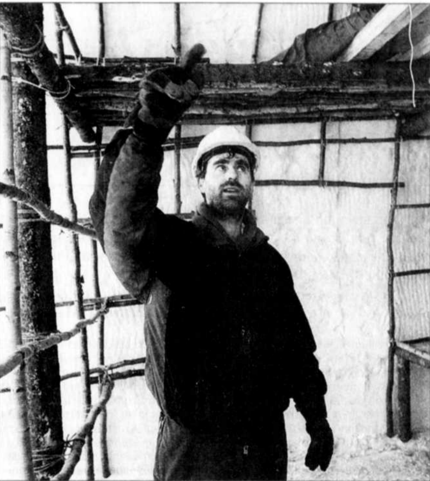
La neige fraîchement produite est compactée sur des gabarits de métal qui seront retirés lorsque la structure sera suffisamment solide.
