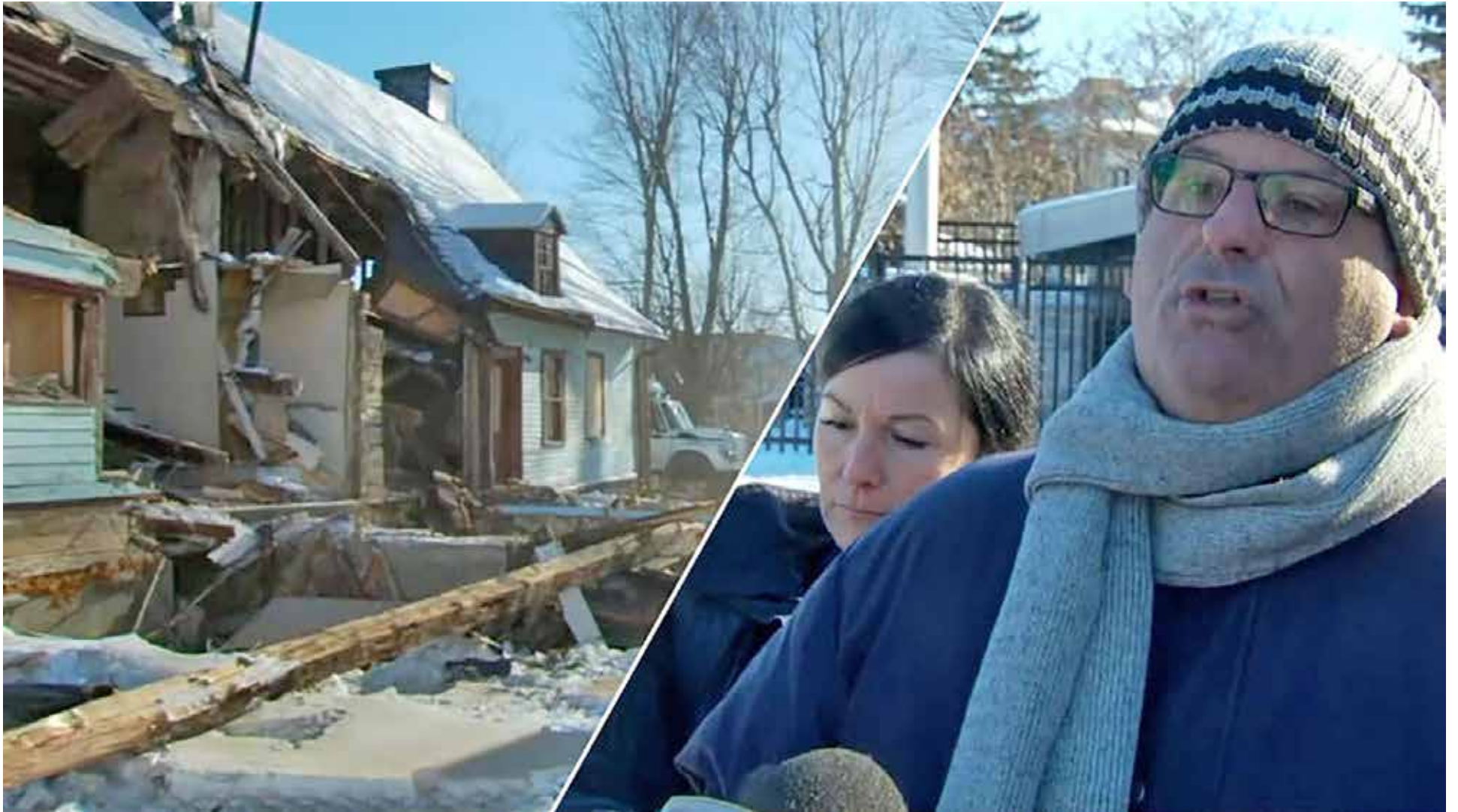
Arrêté alors qu'il tentait d'empêcher les démolisseurs de raser la maison Boileau, l'ancien candidat du Parti québécois dans Chambly, Christian Picard, fait face à des accusations de méfait. On peut contribuer financièrement à la campagne « Soutenons la défense de Christian Picard » sur www.yoyomolo.com .
