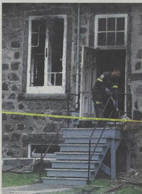
Dur réveil, à Saint-Damase, au lendemain d'un incendie criminel qui a ravagé la sacristie de l'église. Photo Patrick Roger | Le Courrier ©
