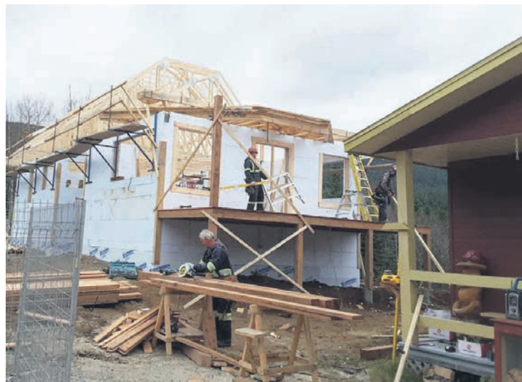
Le nouveau bâtiment d'accueil de la zec des Martres, en construction, a reçu un coup de pouce financier de la part de Québec. Courtoisie
