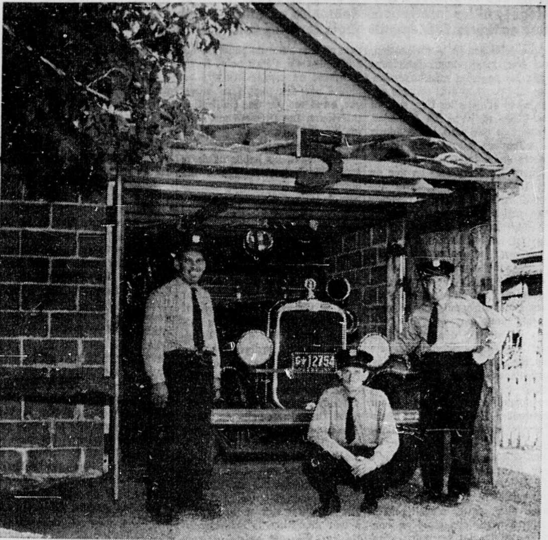
NOUVEAU POSTE DE POMPIERS DANS Val Tétréau—Début de la semaine, deux équipes de deux hommes font la relève jour et nuit dans le quartier Val Tétréau, afin de protéger ce secteur contre tout incendie qui pourrait y naître. On sait que le quartier est temporairement isolé du reste de la ville à cause des travaux de réparation au boulevard Alexandre Taché et que les pom-
