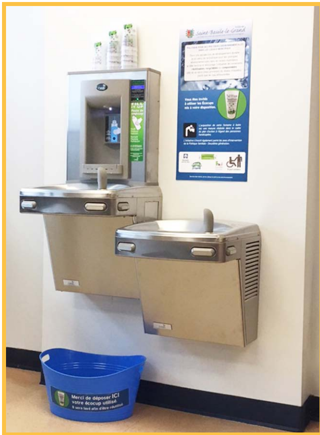
Installation d'une fontaine à boire à triple vocation au centre civique Bernard-Gagnon (2017)
