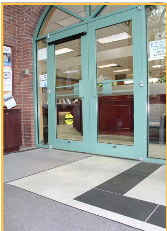
Ajout d'une « bande avertissante » au sol ainsi que de bandes contrastantes sur les portes de verre dans le hall d'entrée de la bibliothèque Roland-LeBlanc (2018)
