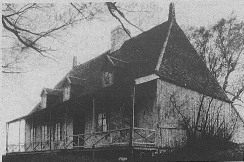
◀ Notons ici une maison photographiée vers les années 1930. Le garde-soleil en rupture avec la ligne des versants et la grande galerie furent construits à la fin du XIXe siècle.
