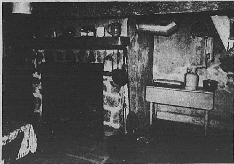
◀ La cheminée principale avant la restauration. L'enlèvement de la fausse tablette et du revêtement de pierre de granit a révélé un foyer extraordinaire.
