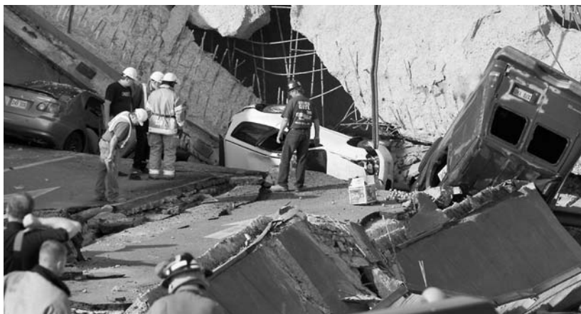
Effondrement du Viaduc de la Concorde, le 30 septembre 2006
