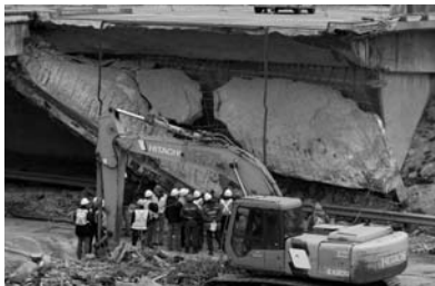
Inspection du viaduc de la Concorde
