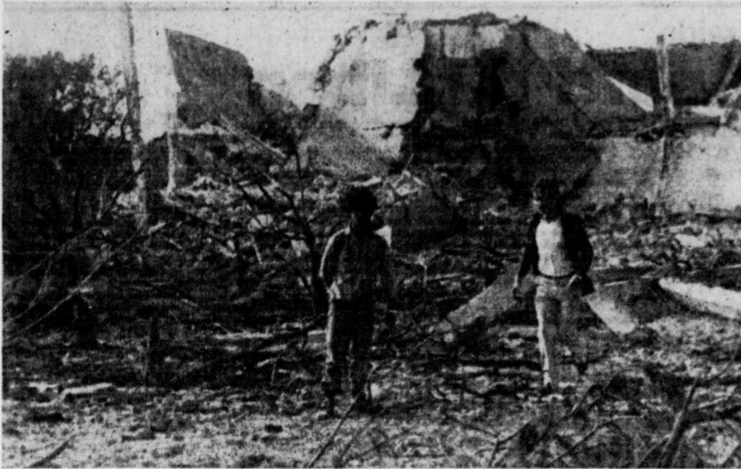
Après le passage d'un avion israélien transportant des bombes, tout n'est que ruines. Ces deux jeunes gens en ont fait la constatation.
