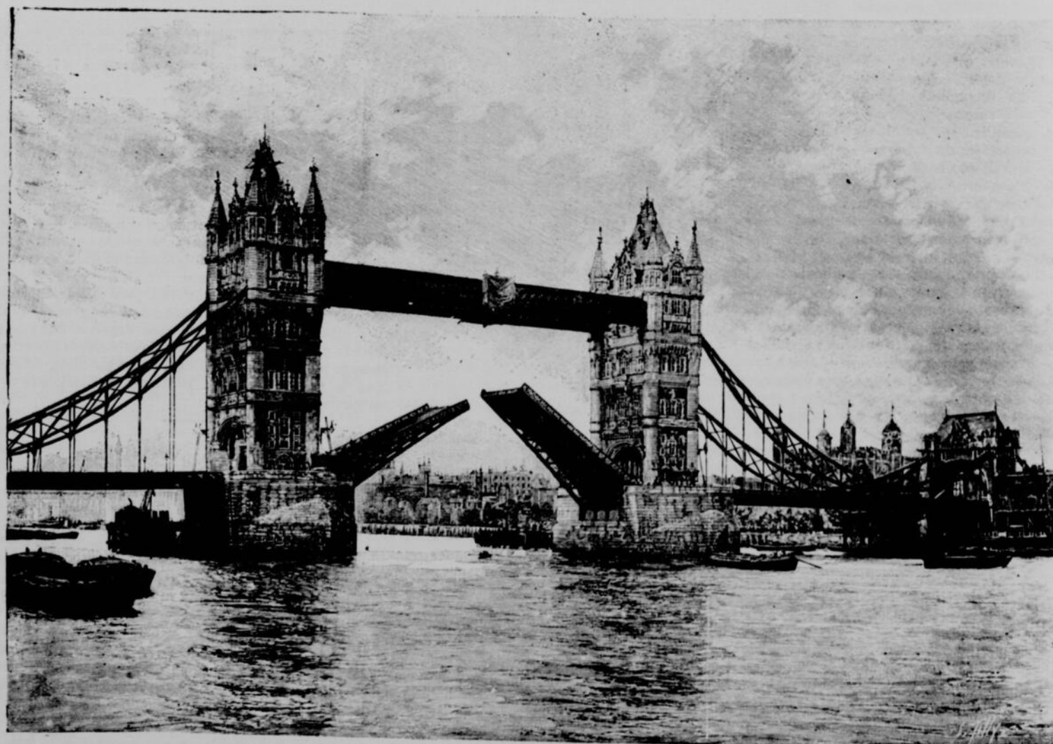
LONDRES. — LE NOUVEAU PONT DE LA TOUR : RELÈVEMENT DES DEUX PARTIES MOBILES DU TABLIER
