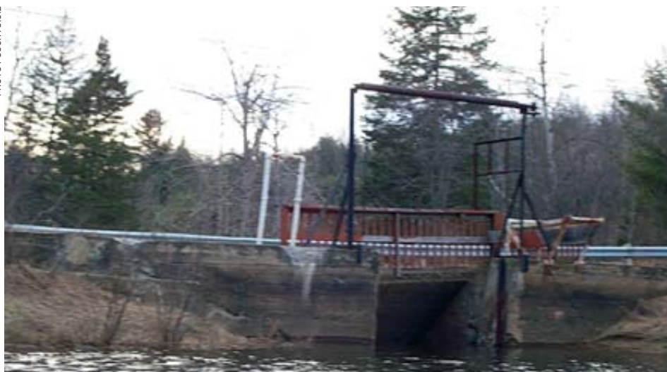
Le barrage au lac Paquette est un ouvrage dont la construction remonte aux années 50.
