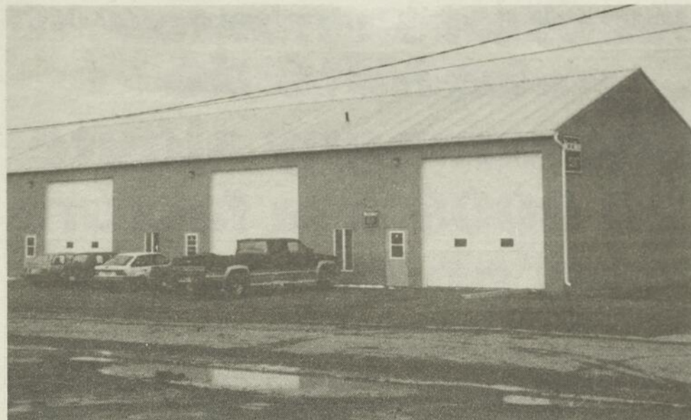
On procède actuellement à l'agrandissement du motel industriel de Ville de L'Islet.
