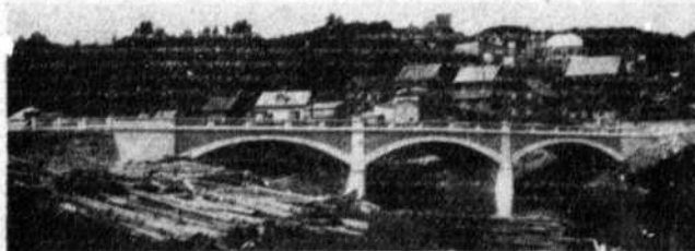
Pont à trois arches en béton armé sur la rivière à Chicoutimi.
