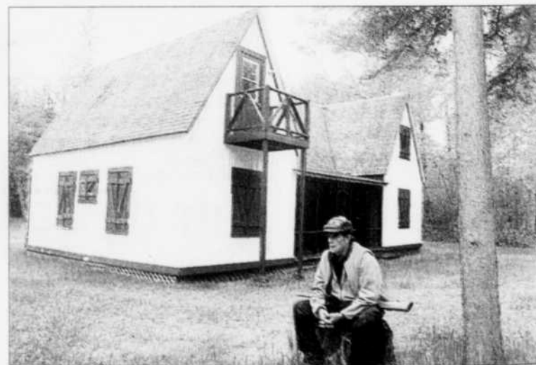
Yvon-Marie Gauthier, vieux guide de pêche sur la rivière, regarde avec désolation le site de Bardville qu'il entretient au minimum en ramassant les branches cassées et en coupant l'herbe qui pousse à l'ombre des bâtiments abandonnés.
