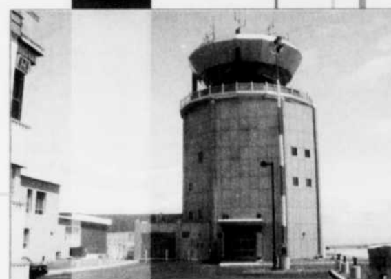
CONSTRUCTION DE LA TOUR DE CONTRÔLE SIR CHARLES BAGOT
