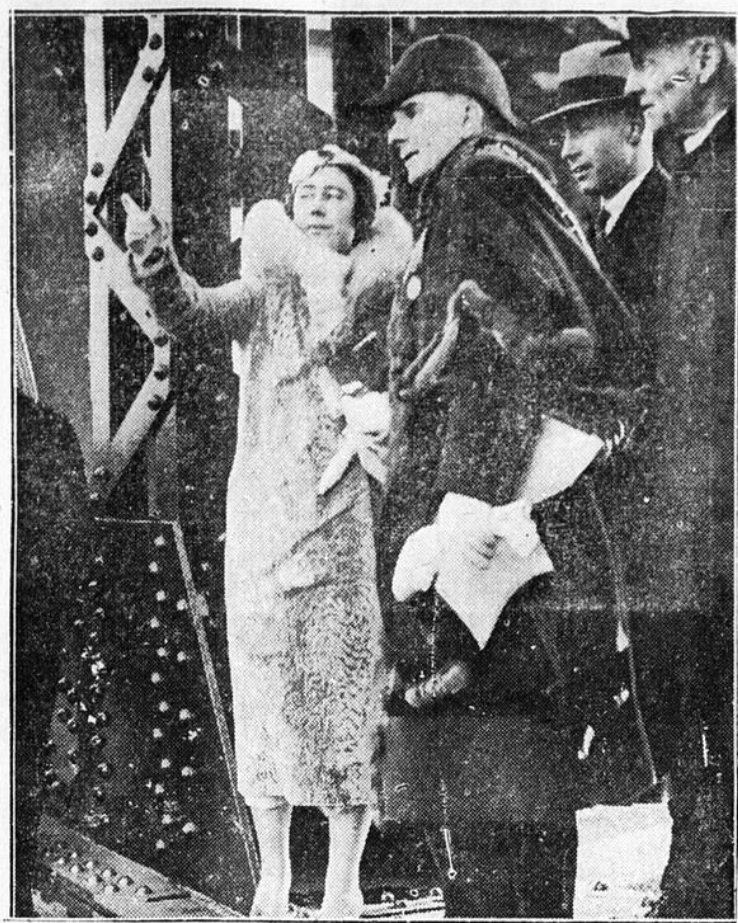
Le Duc et la Duchesse de York ont pris part aux cérémonies qui ont marqué l'inauguration d'un nouveau pont au-dessus de la rivière Tees, à Middlesbrough.
