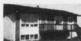
LATERRIERE: 296, rue du Boulevard.
