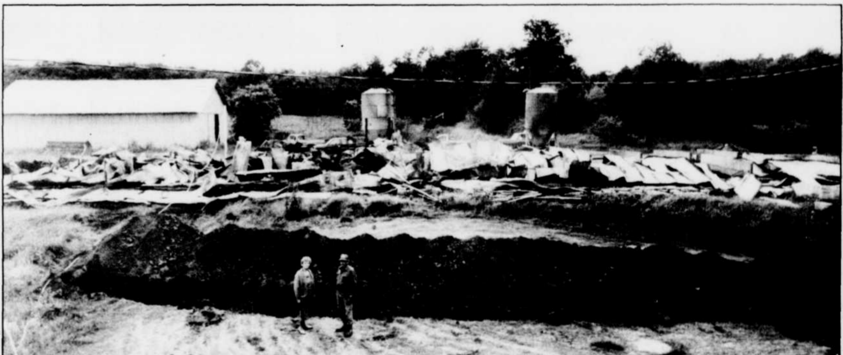
La porcherie détruite par un violent incendie.
