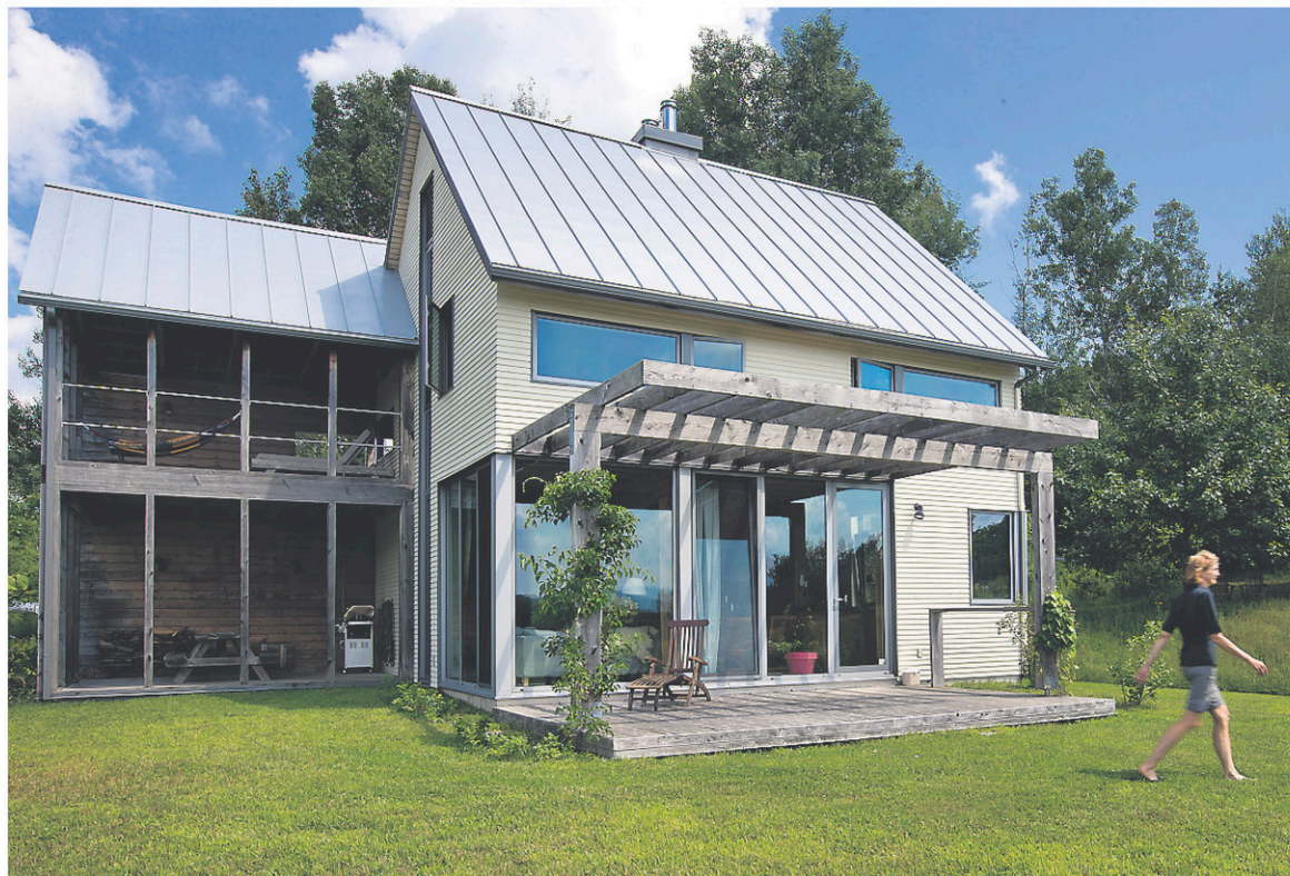
Côté rue, la maison dispose de peu de fenêtres, alors que la façade opposée est abondamment vitrée.
