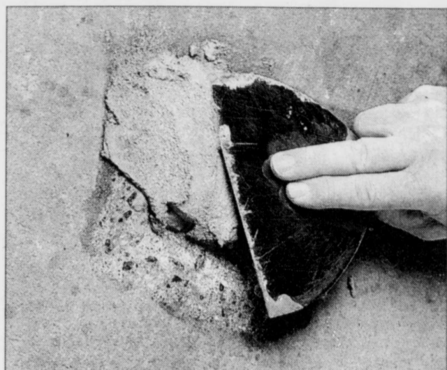
Lissez la surface du mélange de ragréage à béton à l'aide d'un couteau flexible.
