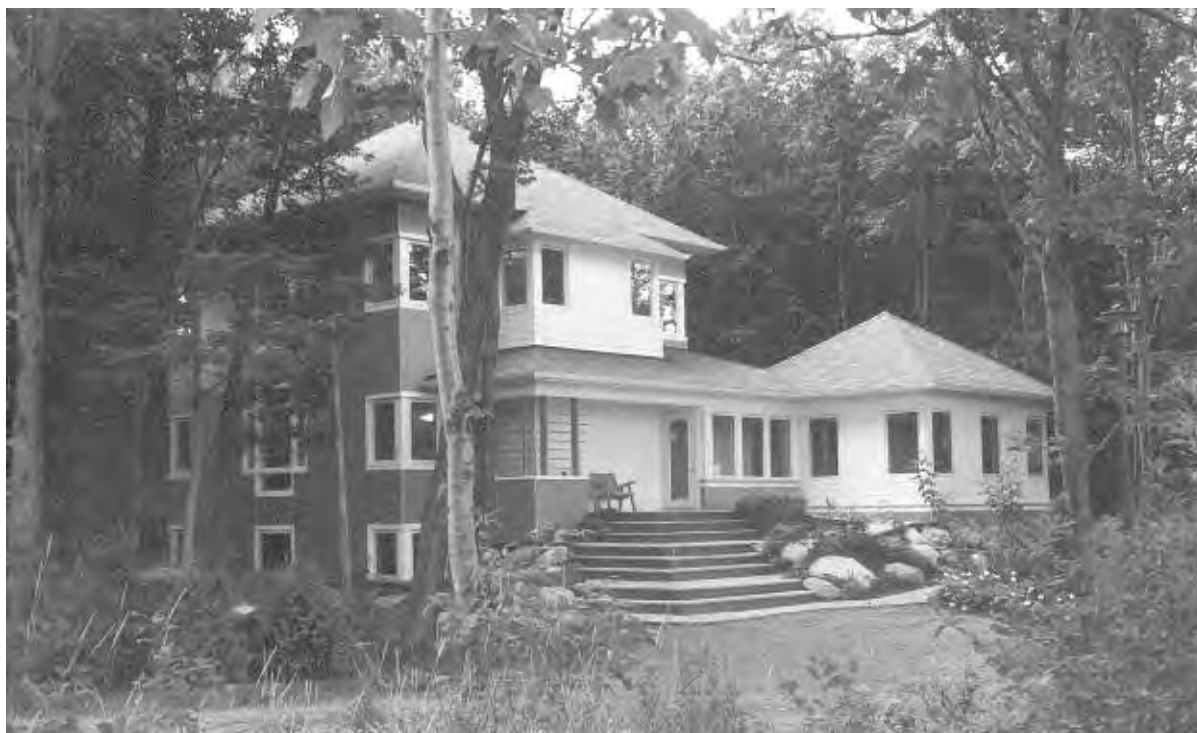
Les bureaux de la firme au 23 de la route 116.
