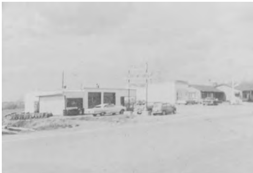
Le premier garage en 1959.
