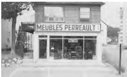
Au début des années 1970, le commerce s'agrandit en prenant le local de la pharmacie J. L. Veillette situé à l'avant du bâtiment. Le second étage était occupé par des locataires.
