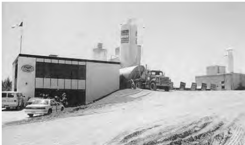
Les installations du 1375 boulevard Jutras Est, alias rang Blanchet, en 1998, et où l'entreprise emménagea en 1965.
