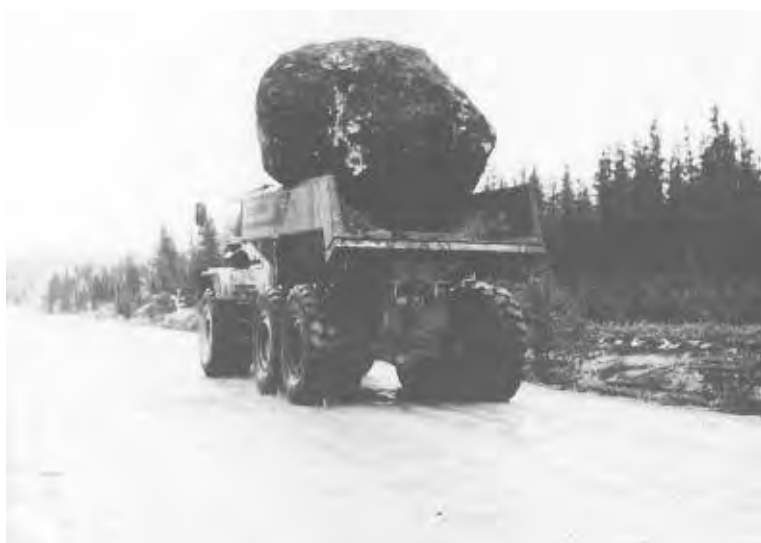
Lors des travaux du poste de La Vérendrye. La roche pèse 25 tonnes.
