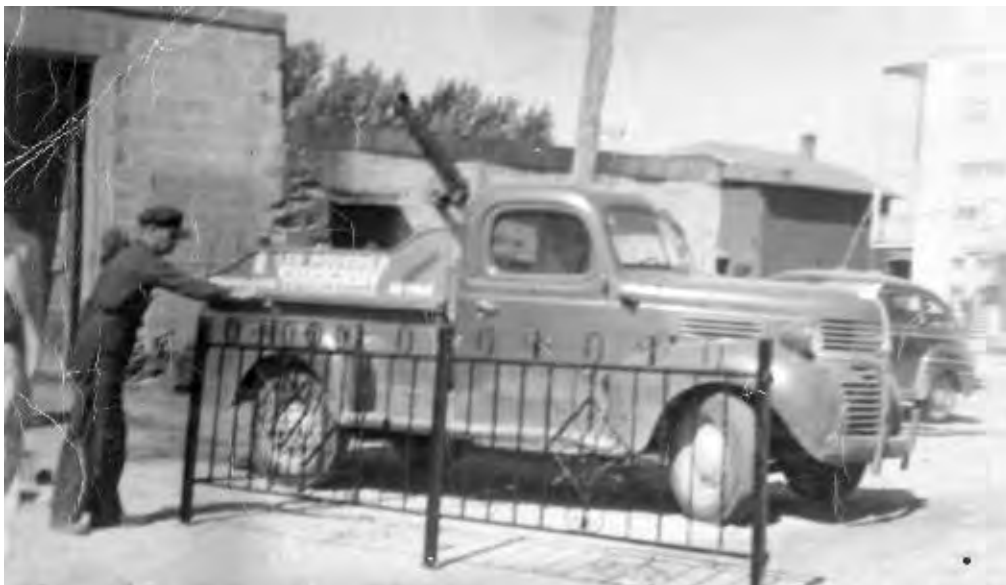
Derrière une rampe de fer ornemental que l'on vient de fabriquer, le premier camion de l'entreprise. À droite, la dernière maison familiale, érigée en 1952 au coin des rues Romulus et Fabiola.
