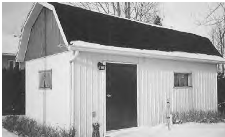
Le premier local de l'entreprise.
