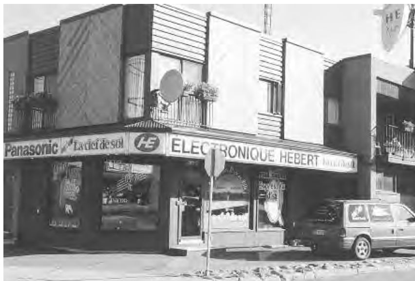
Situés au 12 de la rue Perreault, les locaux de Électronique Hébert ont subi nombre d'agrandissements au fil des ans.
