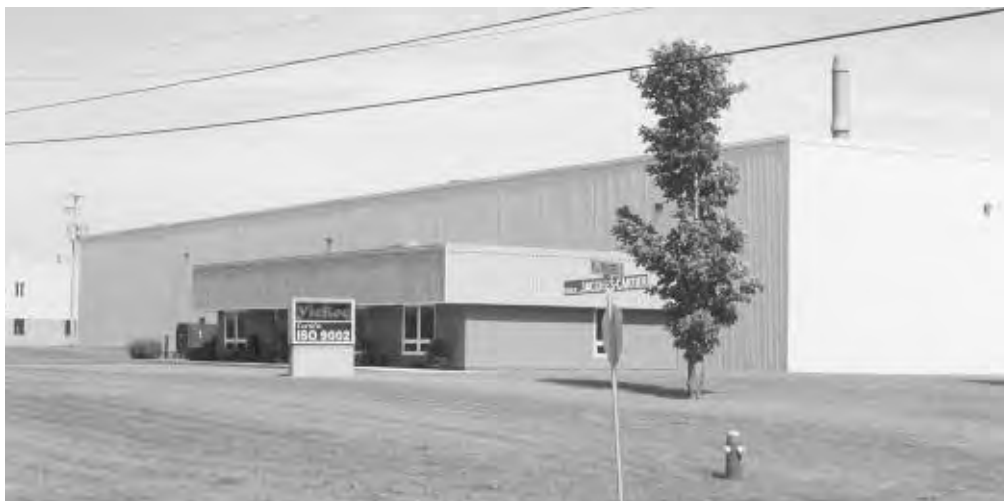
L'usine au 951 boulevard Industriel Est.
