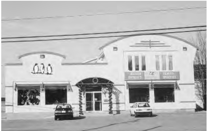
Le magasin après les rénovations de 1999.
