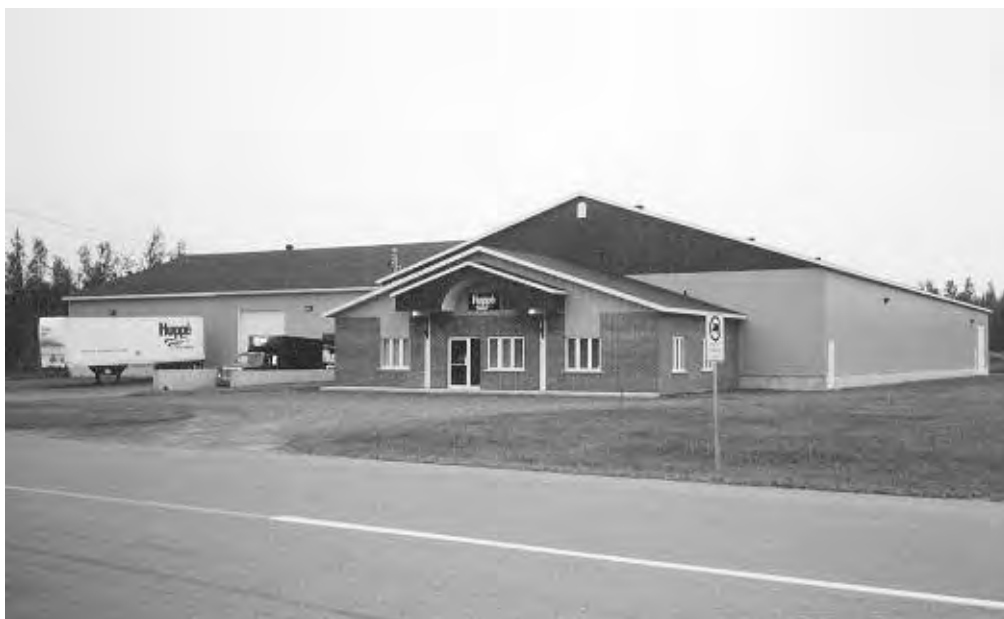
L'édifice situé au 225 rue de la Jacques-Cartier et occupé depuis le 6 juin 1997.
