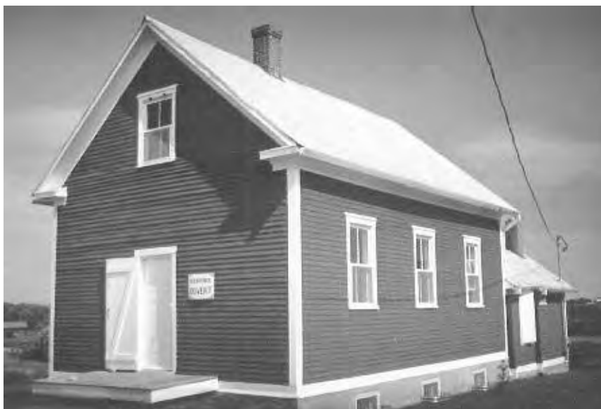
La Maison d'école, construite en 1903, située au 416 avenue Pie-X à Saint-Christophe-d'Arthabaska.
