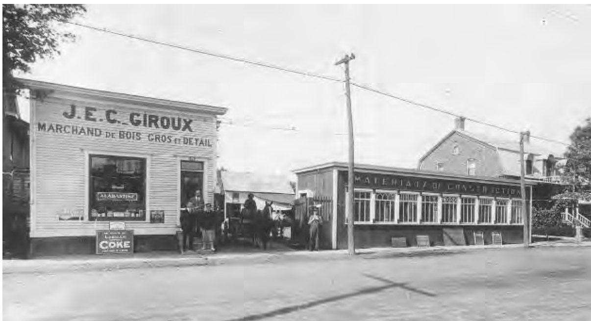
La cour à bois sur la rue Saint-Louis.
