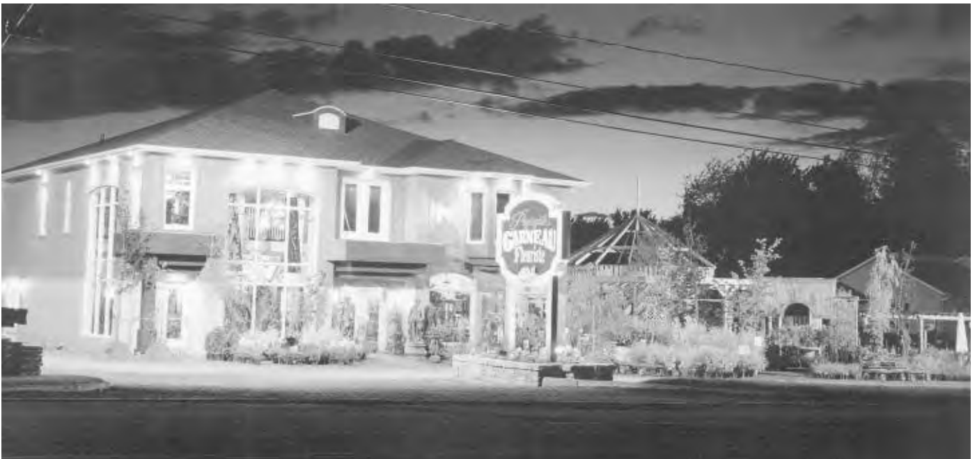
En 1998, l'entreprise prend un tournant majeur et fait construire un tout nouvel édifice auquel on greffera alors une boutique de cadeaux.
