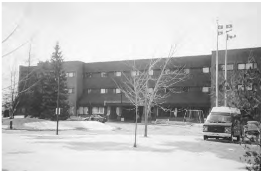
Le Centre hospitalier des Bois-Francis.
