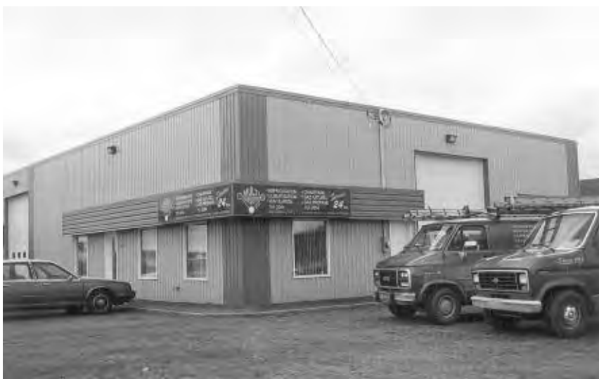
Les installations, au 210 boulevard de la Bonaventure.
