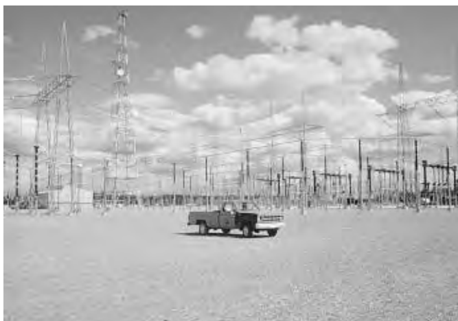
C'est en 1976 que Thiro a étendu ses services et s'est lancée dans la construction de lignes de transport et de postes de transformation.
