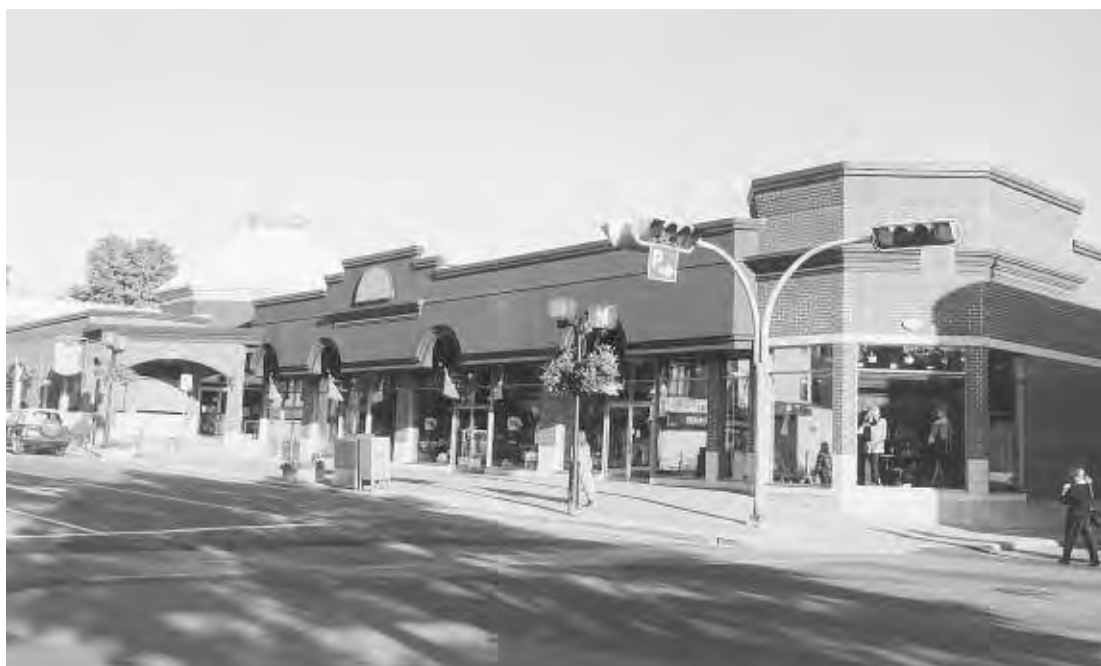
Parmi les travaux réalisés par Construction Gagné et Fils inc. on note ceux de la Place Luxor, sur la rue Notre-Dame Est en 1996.
