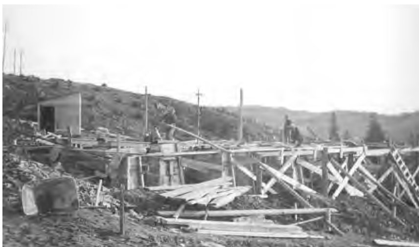
À l'époque où la mécanisation n'était pas encore venue au secours des travailleurs.
