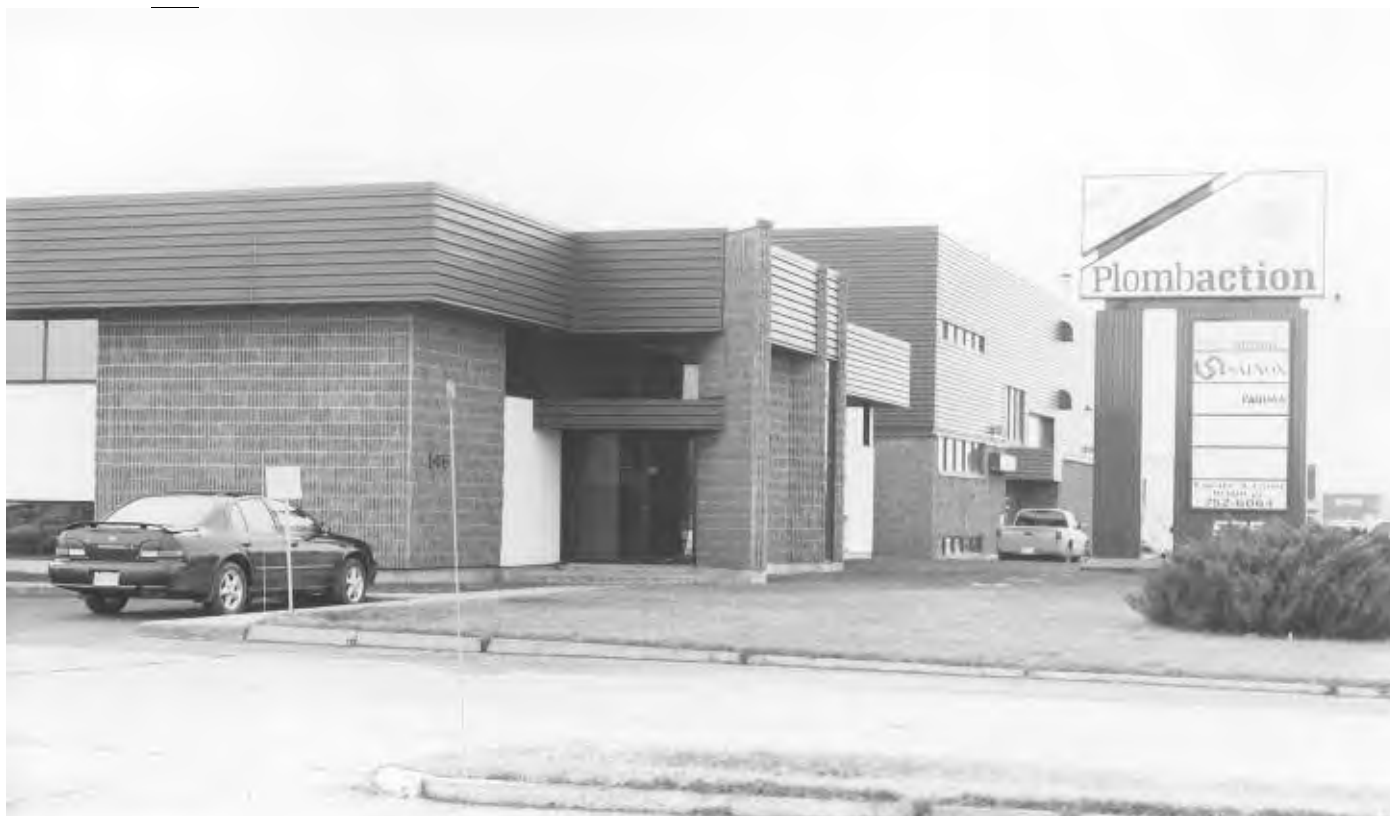
Les installations actuelles de Plombaction situées au 575 boulevard Industriel à Victoriaville.
