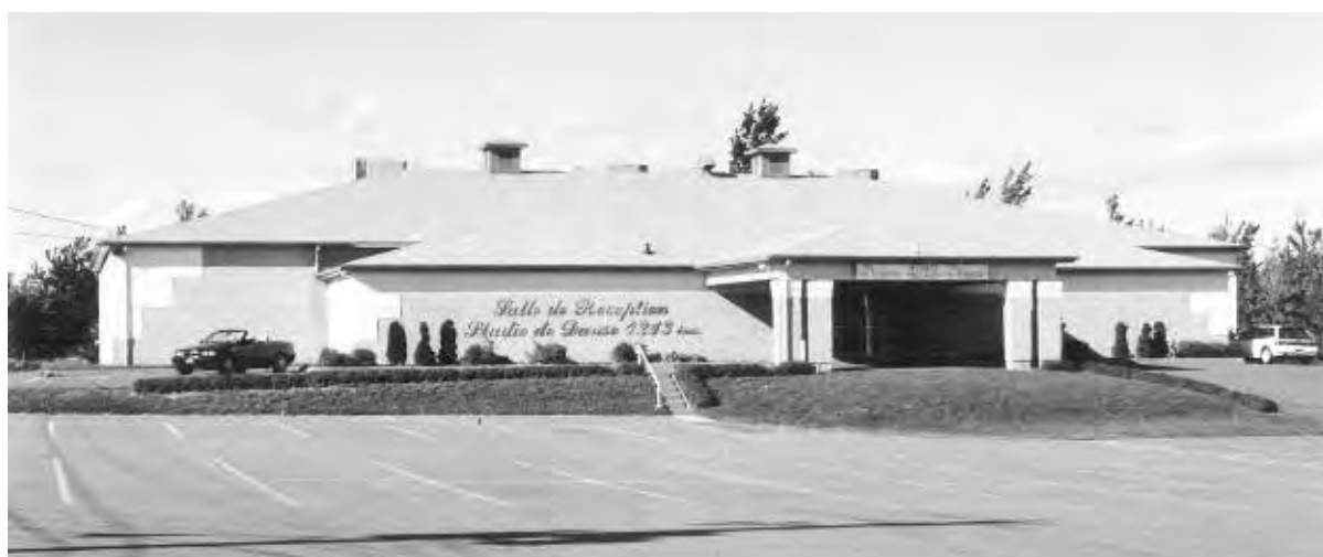
La salle de réception, le 4213, au 990 boulevard Jutras Est.
