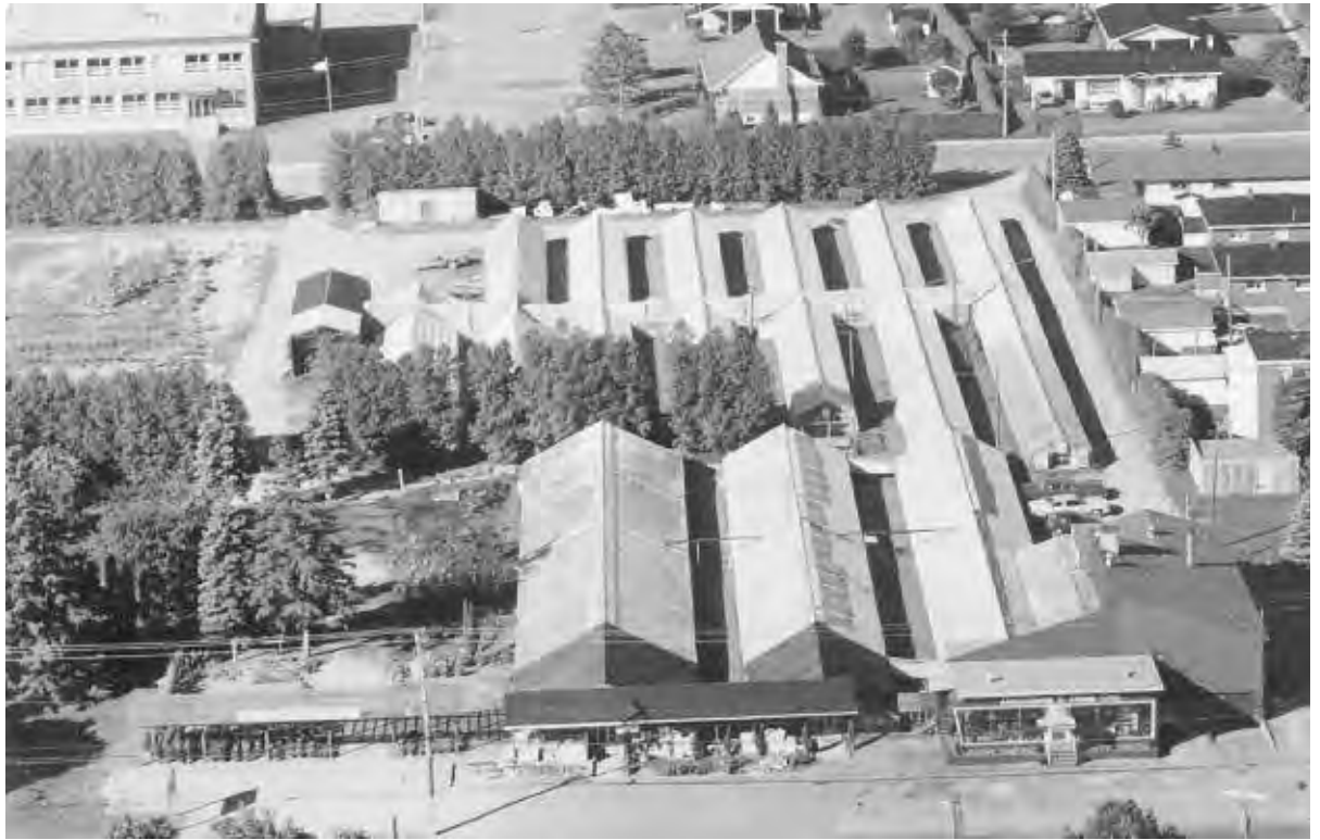
Le nombre impressionnant de serres qu'on pouvait observer à l'époque ne laissait indifférent aucun des usagers du boulevard des Bois-Francis.
