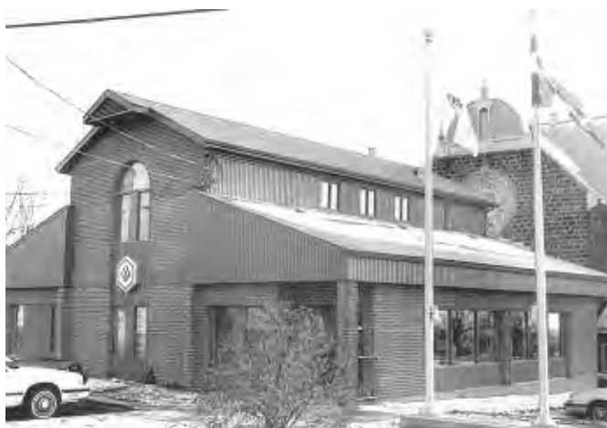
Le centre de services de la Caisse de Victoriaville à Tingwick.
