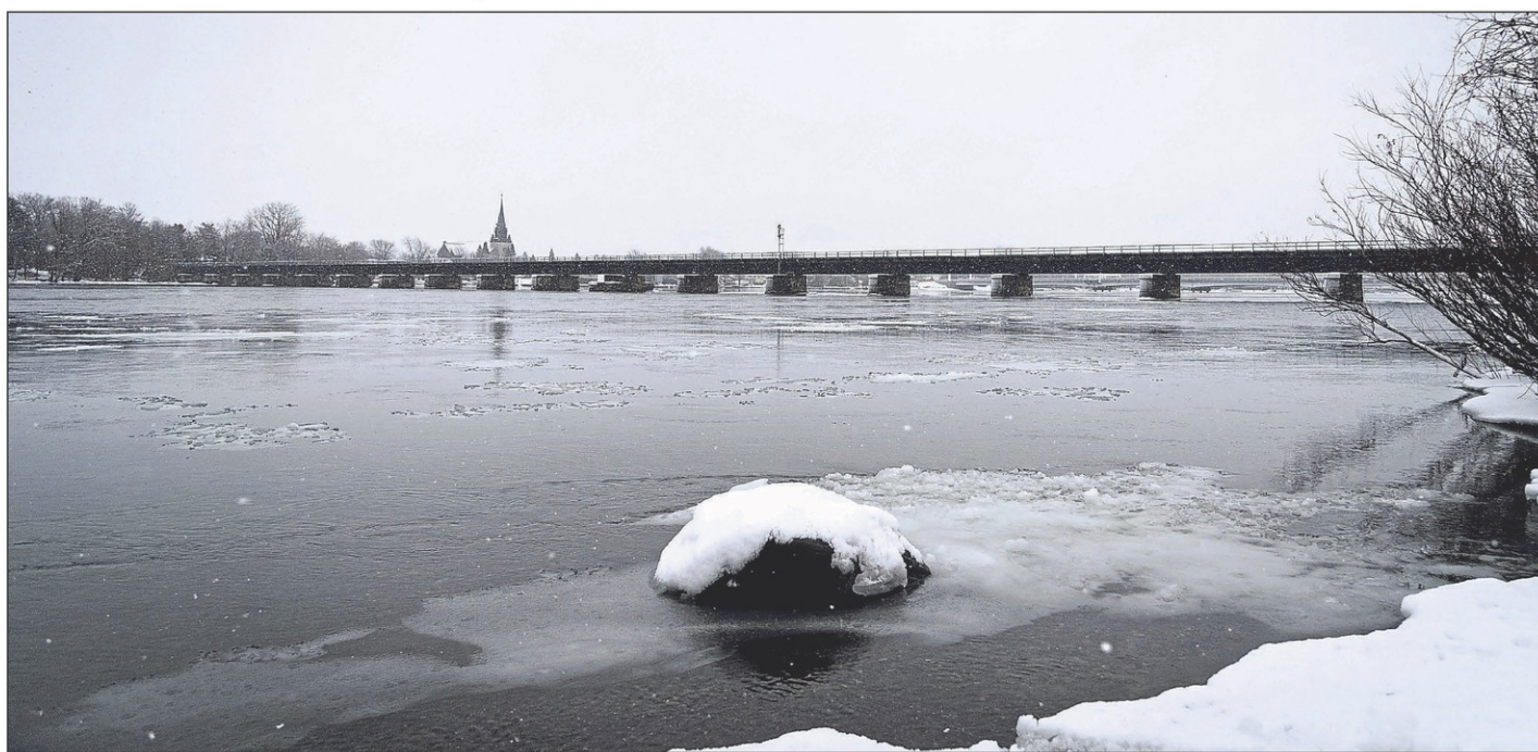
Le Groupe d'étude mise sur des actions dans le haut-fond de la rivière Richelieu pour diminuer les impacts des inondations dans la région. On propose entre autres d'enlever les artéfacts (ex.: pêches à anguilles) et de créer un réservoir submergé entre le pont Gouin et le pont du CN.
