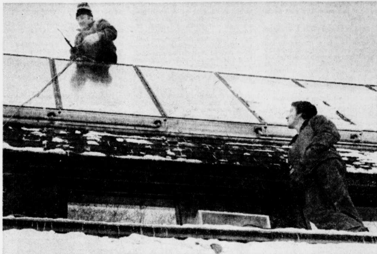
Les capteurs sont de nouvelles dimensions: 3 pieds par 7 au lieu de 3 par 5.
