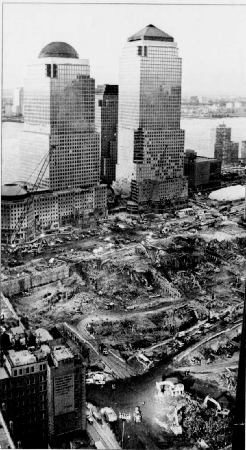
Les travaux de déblaiement des ruines du WTC ont déjà permis l'évacuation de près d'un million de tonnes de débris.
