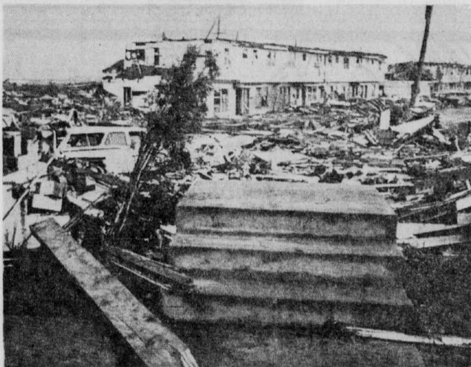
APRES LA TORNADOE — Ces marches d'escalier ne conduisent maintenant nulle part. Une tornade a démolé la maison dans laquelle cet escalier permettait d'entrer. Plusieurs tornades ont balayé la région de Minneapolis. Au moins, 12 personnes ont
