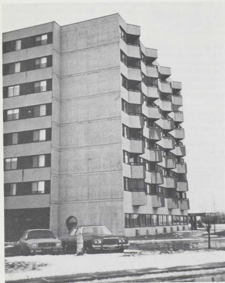
"Le Manoir Cardinal" est une construction de béton armé à l'épreuve du feu, comprenant un rez-de-chaussée de services, et sept étages de quatorze logements, comme l'illustre la photo ci-dessus.
