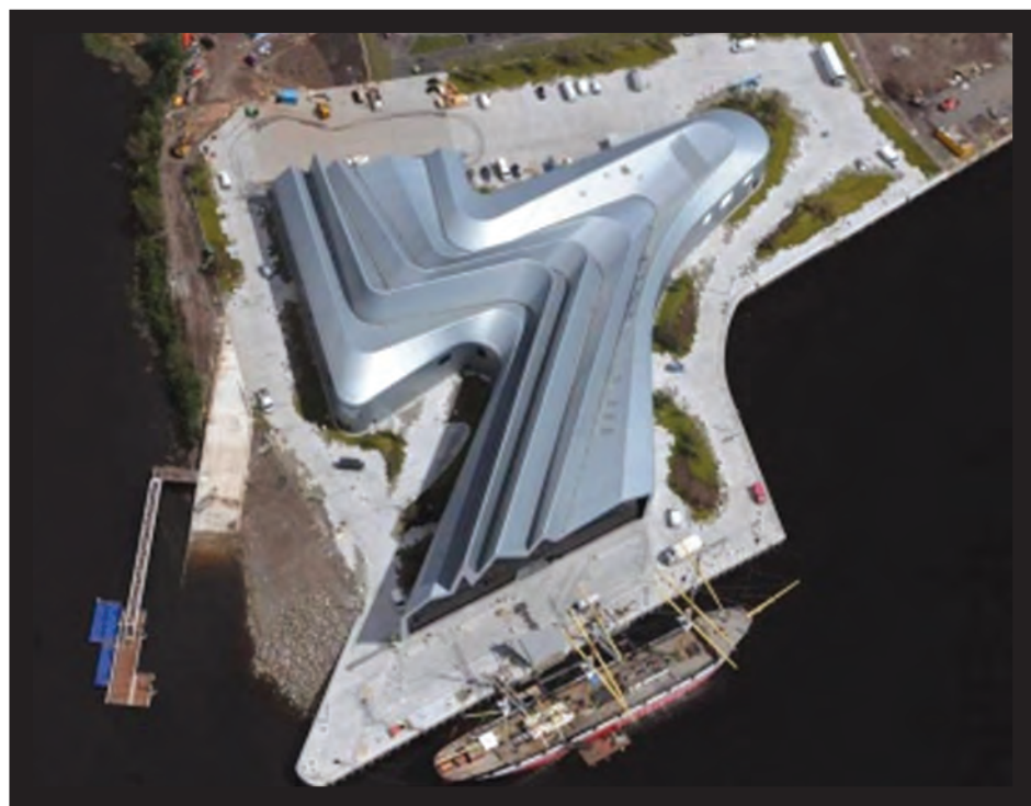
Le Musée du transport Riverside de Glasgow conçu en 2011 par la célèbre architecte britannique Zaha Hadid, décédée tout dernièrement.
