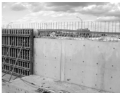
Travaux de la phase 2 effectués l'automne dernier (photo du ministère des Transports).
