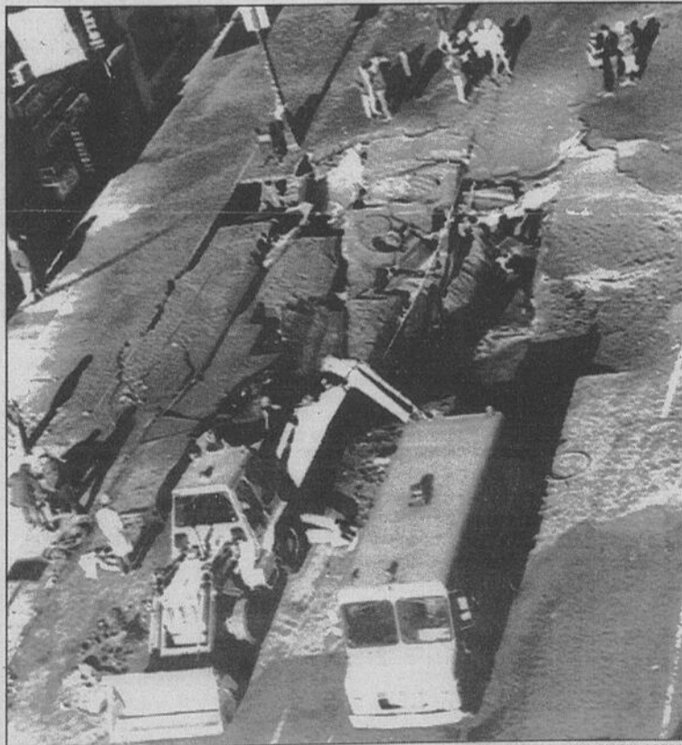
L'éclatement d'une conduite d'eau sous la 5e avenue, à New York, a creusé un cratère de 40' par 35' en plus d'inonder les sous-sols environnants et de paralyser les lignes du métro.
