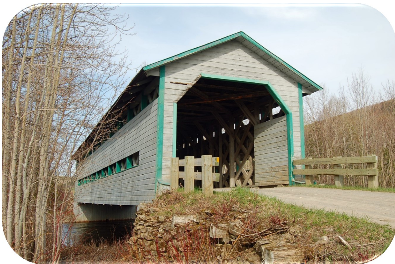
Pont de la Neigette, Saint-Anaclet
