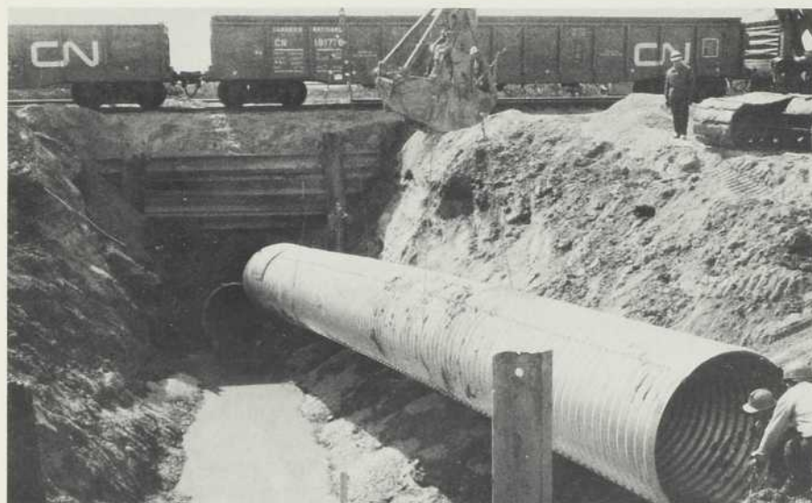
La voie ferrée est restée en service à Fort Francis, Ontario, pendant qu'on installait une canalisation de 60 po. en tôle d'acier galvanisée, à 23 pi. de profondeur.
