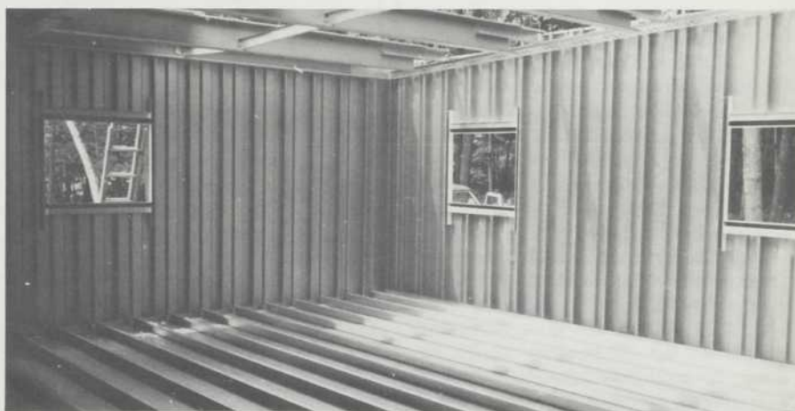
Le sous-plancher en acier recevra un revêtement de contre-plaqué et des carreaux de vinyle. Les murs d'acier seront revêtus de panneaux de plâtre. Un plafond suspendu sera accroché au toit d'acier.
