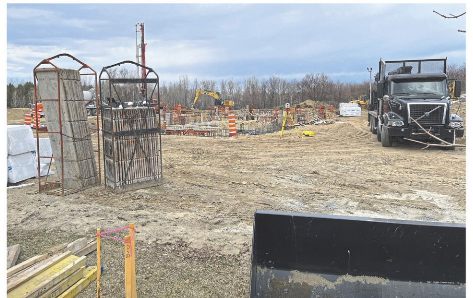
Les travaux en cours sont réalisés par le Groupe Gagné. (Photo www.lanouvelle.net)
