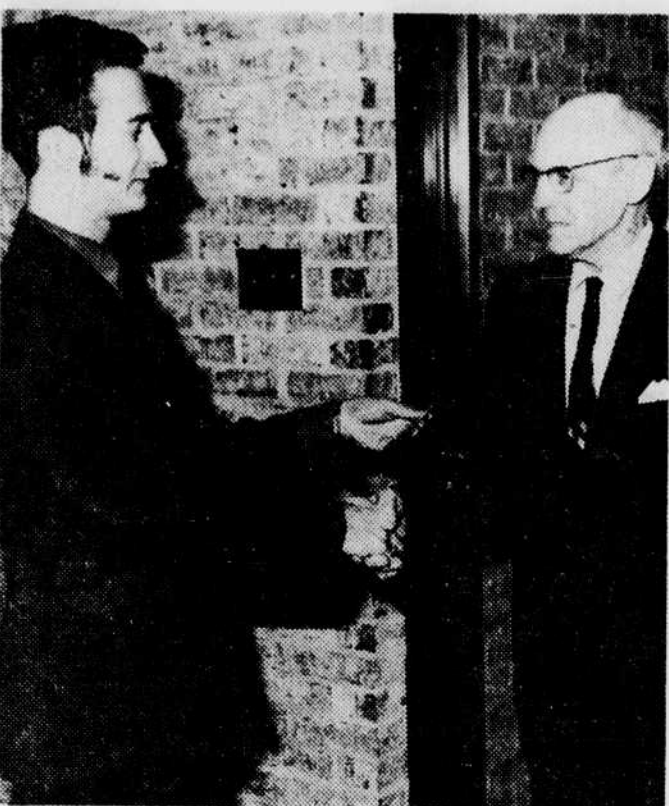
A l'occasion de l'ouverture du Foyer d'Asbestos, M. J.-Y. Poisson, directeur-administrateur du Foyer d'Hébergement d'Asbestos, remet les clés de chambre à M. William Toutant, âgé de 81 ans, qui fut le premier pensionnaire du Foyer d'Asbestos. (Photo Studio Fréchette, Enr.)
