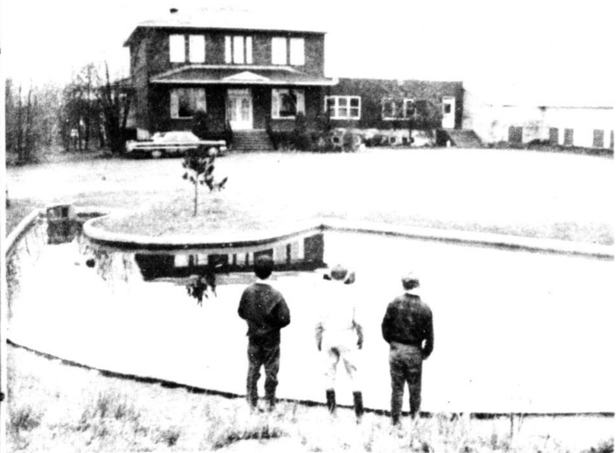
C'EST DANS CET ETANG ARTIFICIEL situé sur le terrain de la Fabrique Saint-Antoine, (Côte-de-la-Réserve) à Chicoutimi qu'un bambin de deux ans et demi, Gilbert Deschênes, s'est noyé, hier midi.
