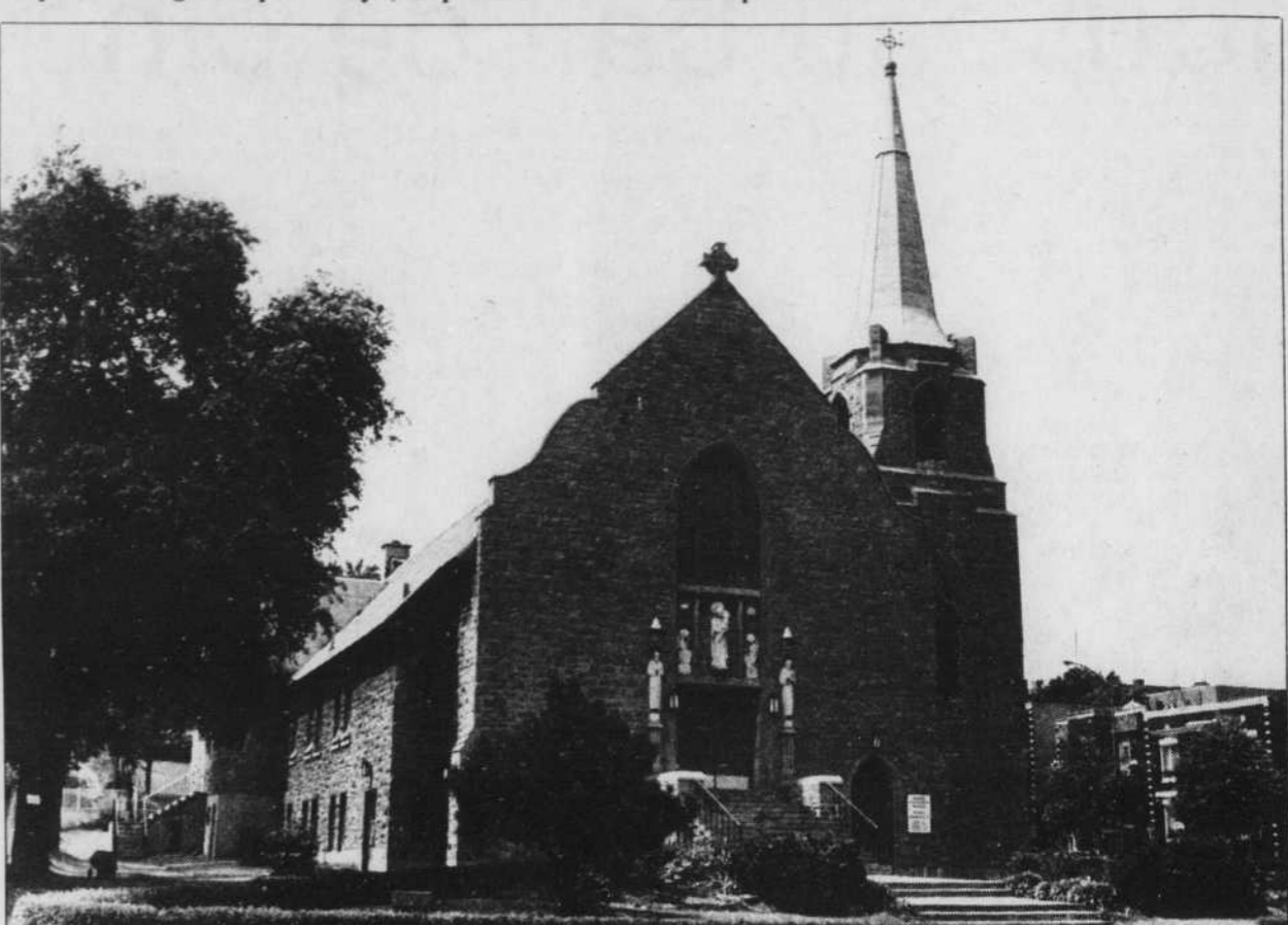
L'église Notre-Dame-de-Czestochowa, angle Hochelaga et Gascon, construite en 1947 par la communauté polonaise, est une des oeuvres les plus originales de Montréal.
