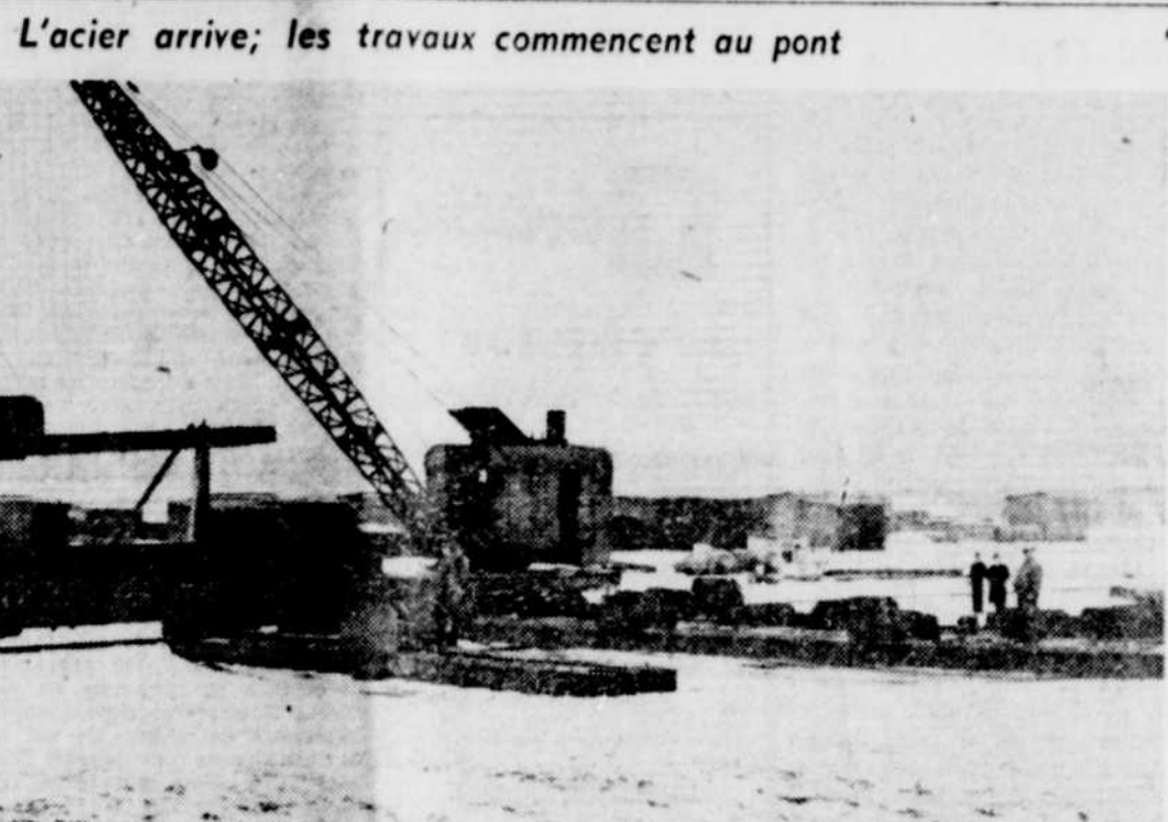
L'acier arrive; les travaux commencent au pont Avec l'arrivée des premiers wagons d'acier provenant de la Dominion Bridge, à Montréal, les travaux ont repris, hier, au pont Duplessis et tout semble qu'ils seront conduits à vive allure maintenant. Cette photo a été prise hier après-midi, sur la voie de construction des tracteries, au Cap-de-la-Madeleine, où la Dominion Bridge a commencé le chargement des premiers wagons d'acier. D'autre part, les travaux préliminaires sont en cours au pont, du côté de l'île St-Christophe. Des employés travaillent actuellement à l'érection d'un pont temporaire avec rails sur lequel une grue géante circulera pour transporter au-dessus de la rivière et mettre en place les lourdes poutres d'acier de la structure du pont. On prévoit que la Dominion Bridge laissera la place à la Dufresne Engineering pour le coulage de la surface de béton vers la mi-août. — (Photo: The Nouvelliste)
