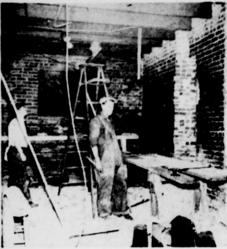
Les employés de la cité transfèrent l'ancien, carré à charbon et à cendres en une salle propre qui servira à l'adressographie. On récupère ainsi un local, devenu inutile avec le nouveau système de chauffage à l'huile. On voit ici les ouvriers à l'ouvrage. Le mur séparant les deux carrés a été défoncé, ainsi que le mur de la voûte. À droite, une porte donnera directement de la salle de l'adressographie à la voûte où sont gardées les archives. À remarquer l'épaisseur du mur de briques.
